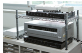
▲改修を終えた放送設備
