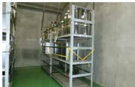
浸水による土壤汚染防止対策(下段の不使用等)
